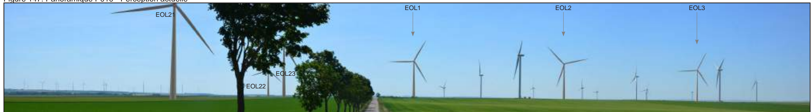
Figure 148: Panoramique P010 - Perception après construction du projet de Viâpres-le-Petit et des autres projets accordés
