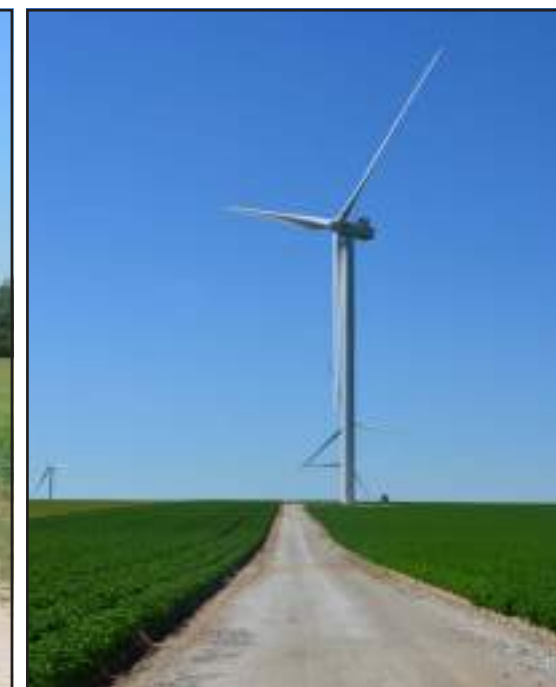
Figure 43: Eolienne sur le site
