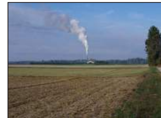
Figure 24: Usine de déshydratation de Pleurs
