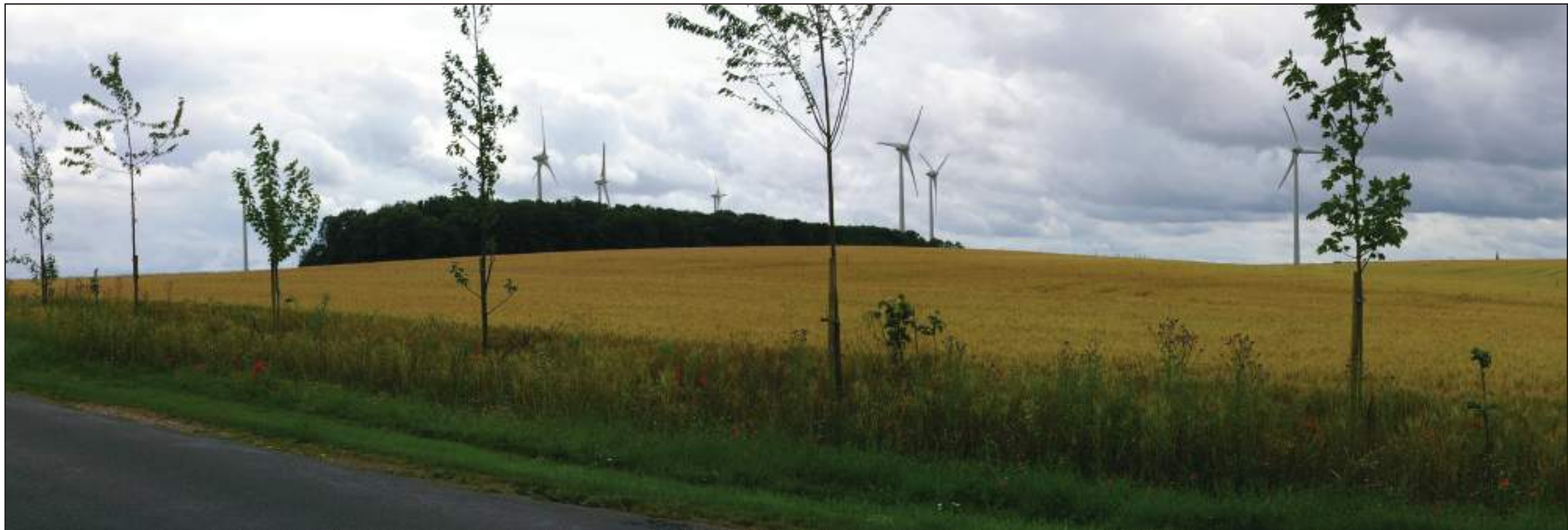
Figure 4: Image en haut : photomontage réalisé pour l'étude d'impact du parc éolien de Garcelles-Secqueville - en bas : la même prise de vue après construction des éoliennes
