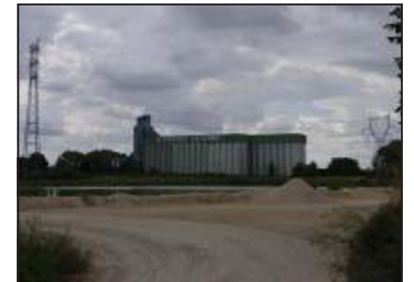
Figure 33: Silos à Mesgrigny
