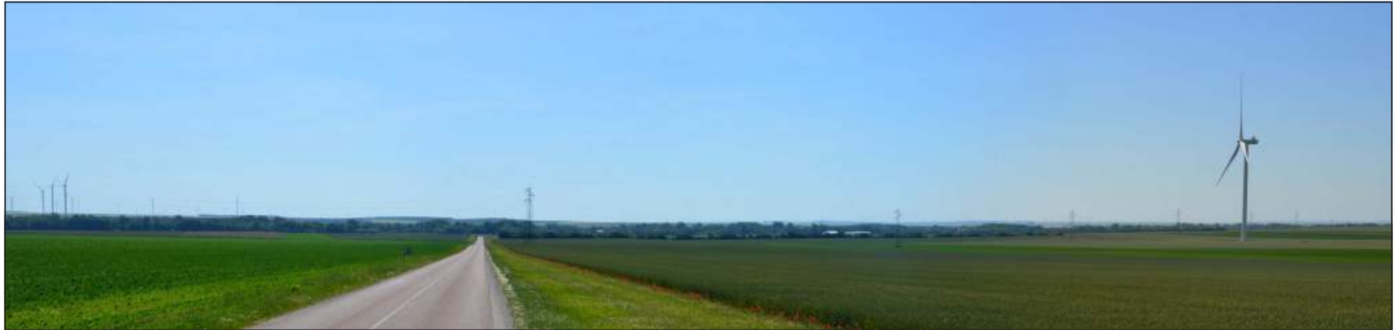
Figure 50: Vue 01 : la RD71 traverse le site du projet. Droit devant Allibaudières, à gauche, une éolienne du parc éolien des Renardières
