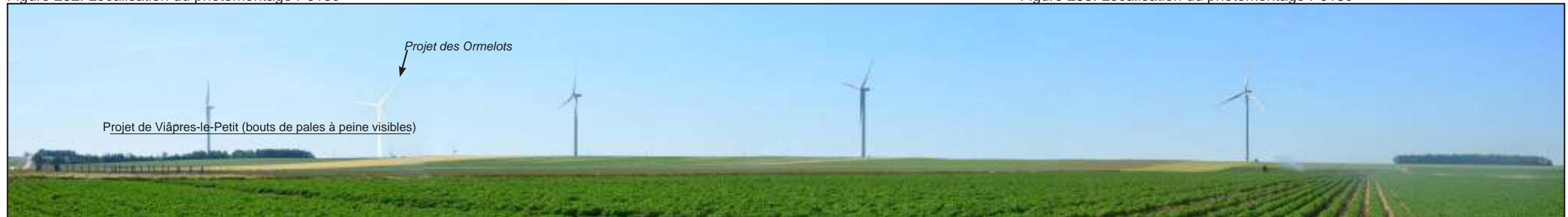
Figure 284: Panoramique P013c - Perception après construction du projet de Viâpres-le-Petit et des autres projets accordés
