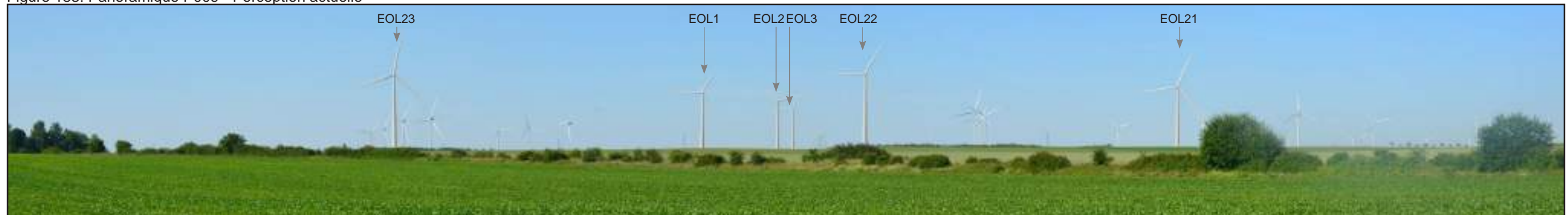
Figure 184: Panoramique P009 - Perception après construction du projet de Viâpres-le-Petit et des autres projets accordés
