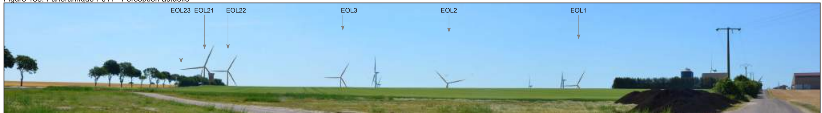
Figure 189: Panoramique P011 - Perception après construction du projet de Viâpres-le-Petit et des autres projets accordés
