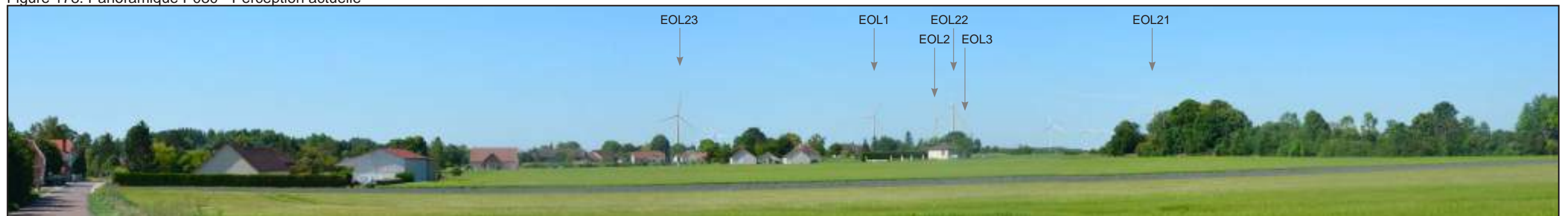
Figure 179: Panoramique P030 - Perception après construction du projet de Viâpres-le-Petit et des autres projets accordés
