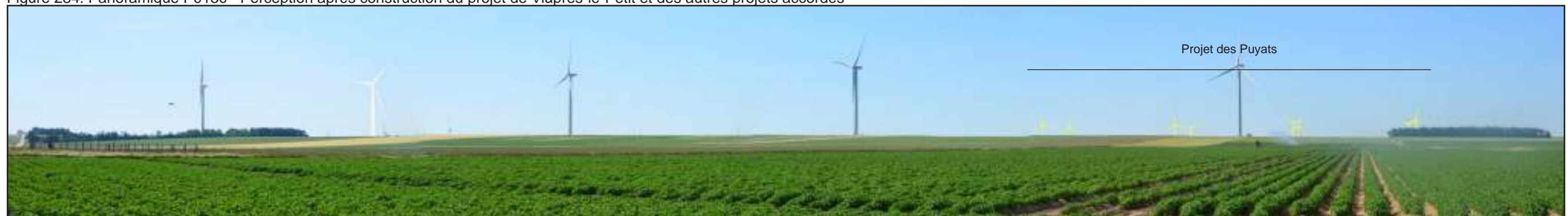
Figure 285: Panoramique P013c - Perception après construction du projet de Viâpres-le-Petit, des autres projets accordés et du projet des Puyats
